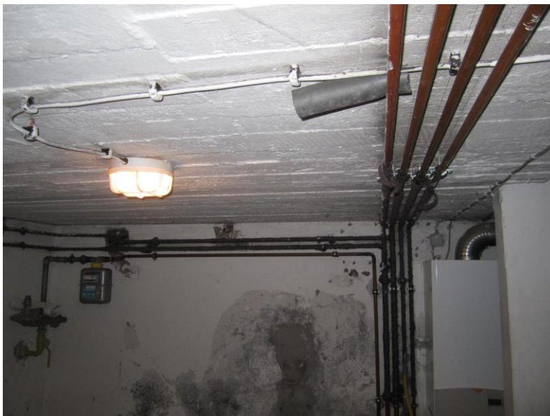
Abbildung 25 ungedämmte Warmwasserleitungen im kalten Keller
