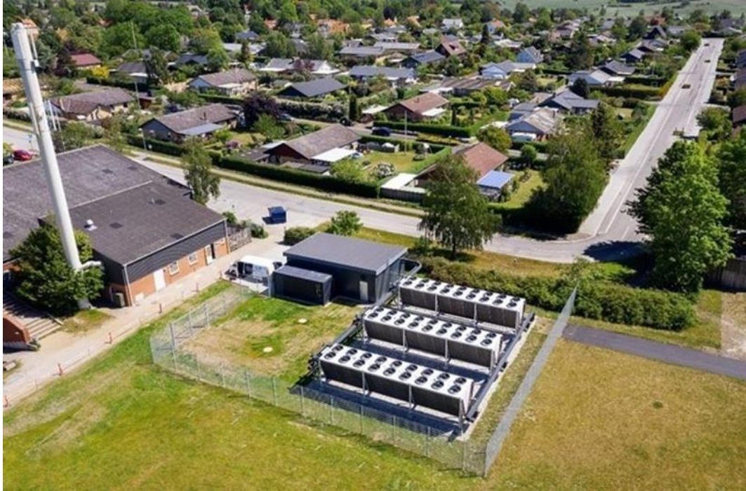
Abbildung 24: 1, 2 MW Luft-Wärmepumpe in Slagslunde Dänemark 23
